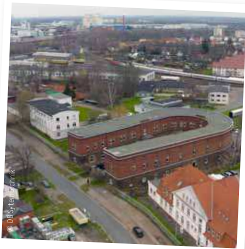
Mit dem RailCampus OWL wird ein neues, bundesweit einzigartiges Innovationsökosystem realisiert.
