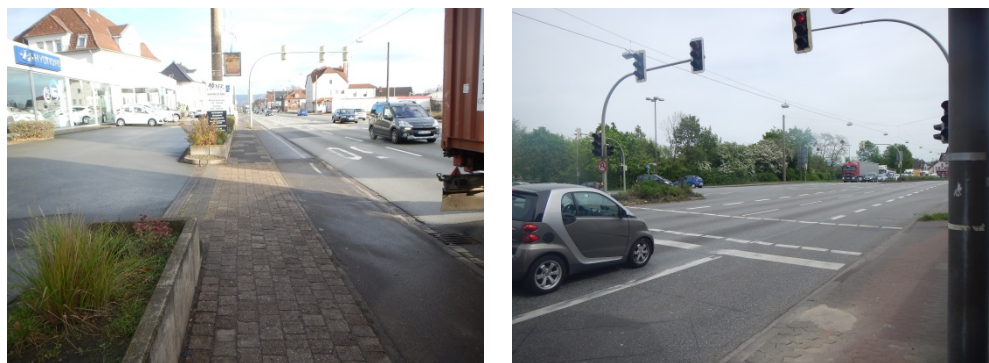
Bild 6-41 Mindener Straße, Kanalstraße
