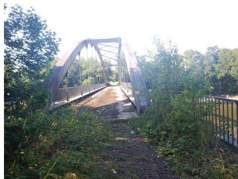
Bild 6-72 Brücke der ehemaligen Bahntrasse der MKB
