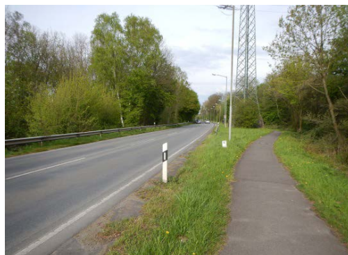
Bild 7-33 Bündler Straße: Einengung durch Oberleitungsmast (Löhne)
