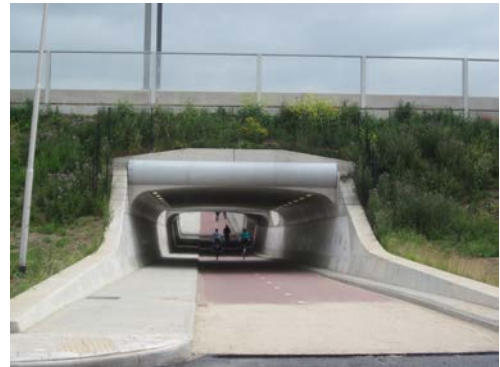
Bild 7-11 Planfreie Querung für den Radverkehr im Zuge eines Radschnellweges (Nijmegen, Niederlande) Foto J. Krause)
