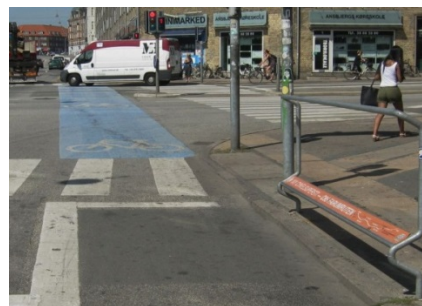
Bild 7-21 Trittbrett an einer Lichtsignalanlage
