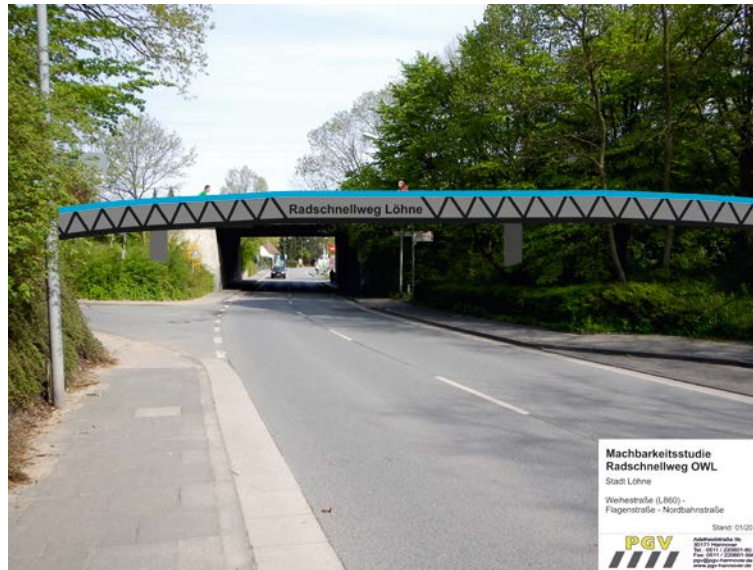
Bild 7-48 Ansicht der neuen Brücke über die Weihestraße (L 860), Blickrichtung Nord
