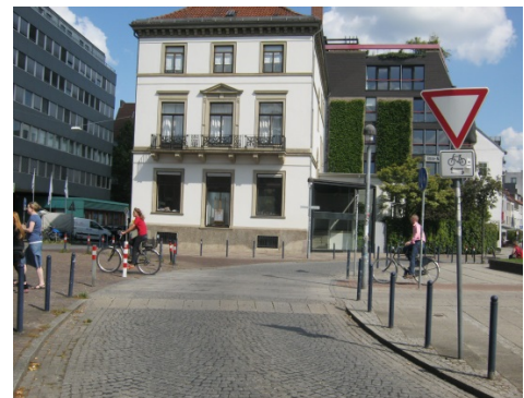
Bild 7-10 Aufgepflasterte bevorzugte Querungsstelle eines selbstständig geführten Radweges (Bremen)
