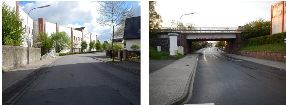
Bild 6-16 Waltgerstraße (links) und Eimterstraße
