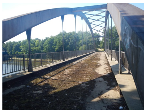
Bild 6-68 Brücke der stillgelegten MKB-Bahntrasse
