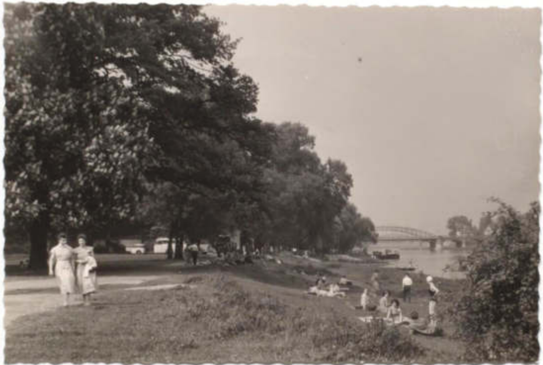
Abb. 22 Partie im Weserglacis. Blick Richtung Norden auf die Weserbrücke. Die Wege am Ufer sind noch nicht zur Promenade ausgebaut. Foto, vor 1973 (KOMMUNALARCHIV MINDEN)
