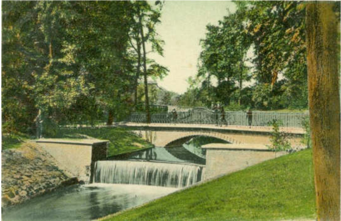
Abb. 9 Blick Richtung Südwesten auf die dritte Bastaubrücke (heutige Verbindung in Richtung Weserstation). Das Bastauwehr diente als Stauanlage. Durch das Drei-Stufen-Gefälle entstand ein kleiner Wasserfall. Postkarte, nach 1904 (KOMMUNALARCHIV MINDEN)
