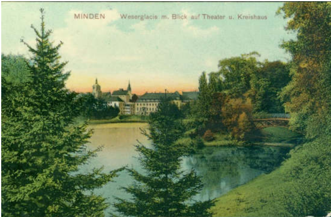
Abb. 41 Partie im Weserglacis. Blick über den Schwanenteich Richtung Norden. Am rechten Bildrand ist die 1904 errichtete zweite Bastaubrücke zu sehen. Kolorierte Postkarte, nach 1904. (KOMMUNALARCHIV MÜNDEN)
