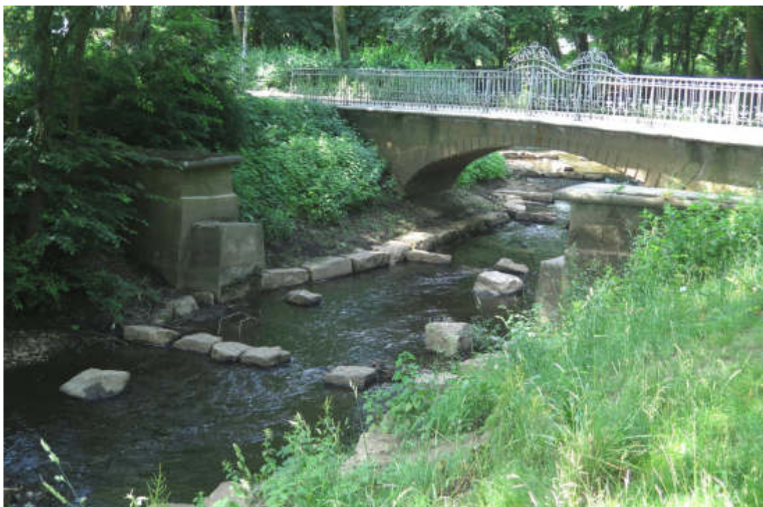
Abb. 24 Ähnliche Perspektive heute. Durch den Rückbau des Stauwehres hat sich das historische Bild verändert. Heute führt die Weserpromenade über die Brücke. Foto, Juni 2018 (LAE 2018)
