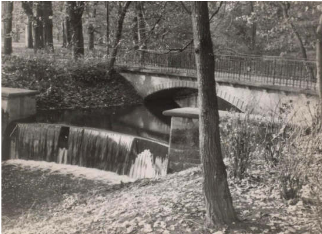
Abb. 23 Weserglacis. Blick auf die dritte Bastaubrücke Richtung Westen. Zustand der Stauanlage mit Wasserfall vor der Umgestaltung 2015. Foto, ohne Datum (KOMMUNALARCHIV MINDEN)
