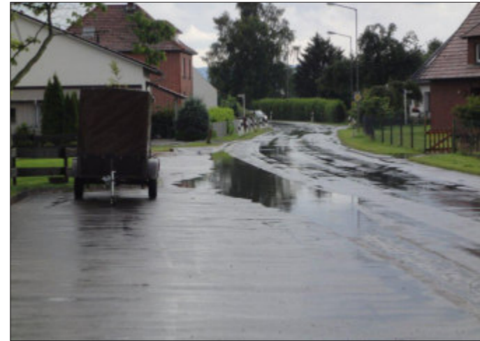
Abb. 12: Mangelhafte Regenwasser-Ableitung an der Päpinghauser Straße (Foto: H. Lüdeling)
