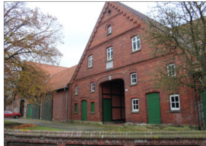
Abb. 16: Hof Böker, 1912, im Hintergrund Deelenhaus mit Fachwerk, 1884 (Foto: H. Lüdeling)
