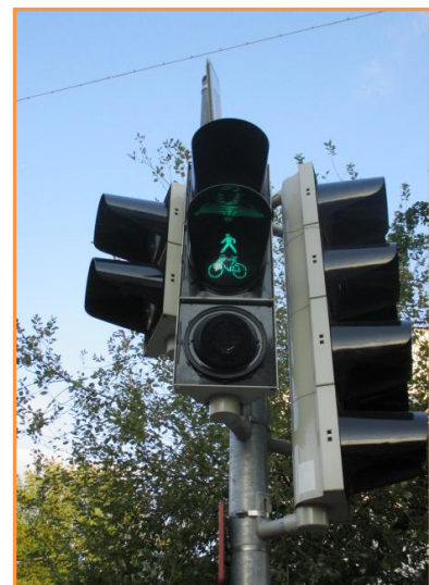
Abbildung 23: Lichtsignalanlage mit in den Ampelkopf integrierter Zusatzeinrichtung für Blinde und Sehbehinderte, Bremen
