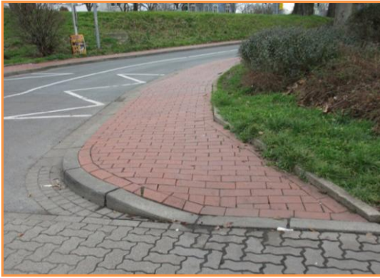
Abbildung 11: Querneigung und unzureichende Absenkung
