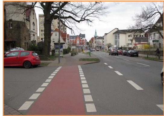
Abbildung 17: Ungesicherte Querungsstelle mit Nullabsenkung
