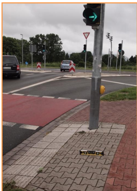
Abbildung 43: Starke Neigung Kaiserstraße an der Ecke Hafenstraße
