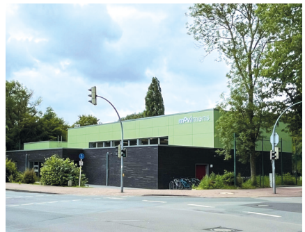
Neubau Einfachsporthalle Ratsgymnasium
